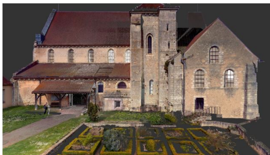
Figure 2 – Nuage de points 3D de la façade Sud de la Collégiale Saint-André
